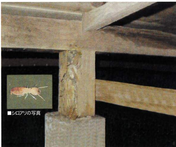
■写真は、床下をシロアリに食害されたイメージ写真です
