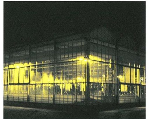
装着後の夜間照明状態(夜間)
